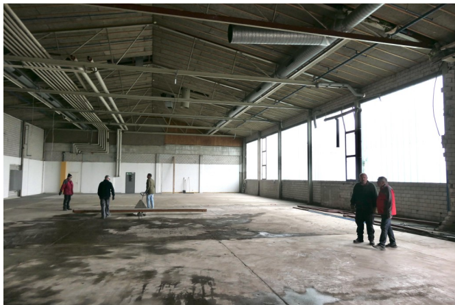
Halle Nord, Blick Richtung Westen
