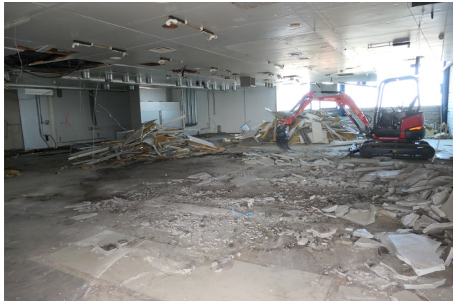
Halle Nord während Rückbau
