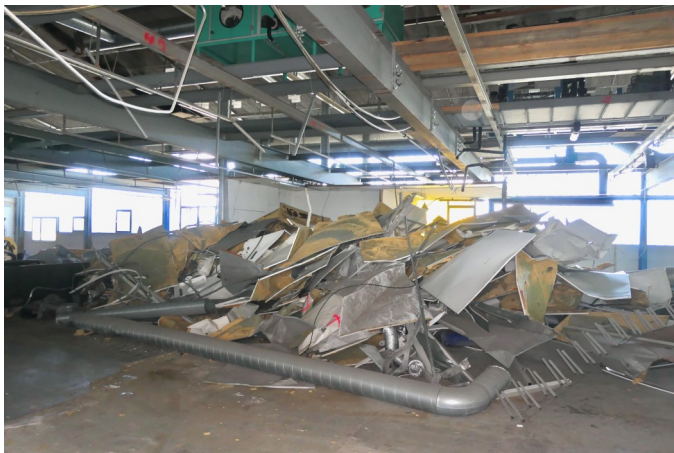
Rückbauschrott in Halle Nord
