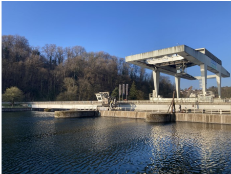
Kraftwerk Schaffhausen Foto von W. Vogelsanger
