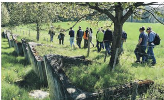
Im Gebiet «Hoobühl» südlich von Schlattigen gibt es viele Panzersperren, die ein Vordringen des Aggressors ins Stammertal verhindern sollten.
