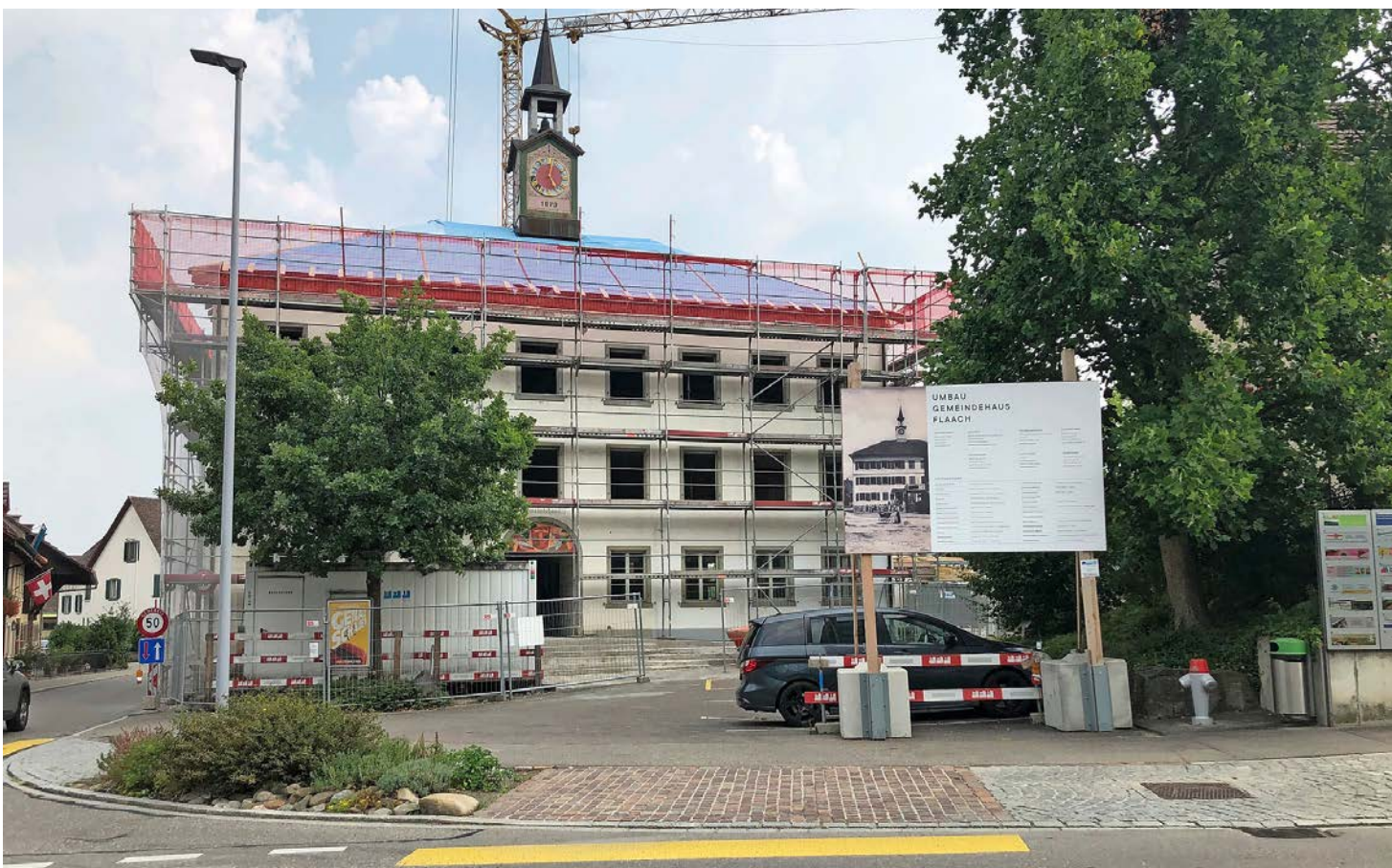
Das Gemeindehaus in Flaach wird derzeit umgebaut. Auf einem öffentlichen Rundgang ist der aktuelle Stand der Arbeiten ersichtlich.
